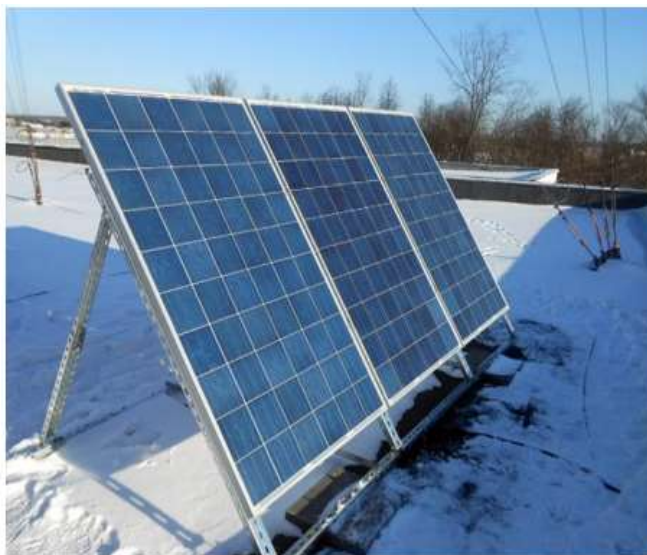
7- сурет - Қуаты 750Вт болатын автономды қуат беру жүйесі
